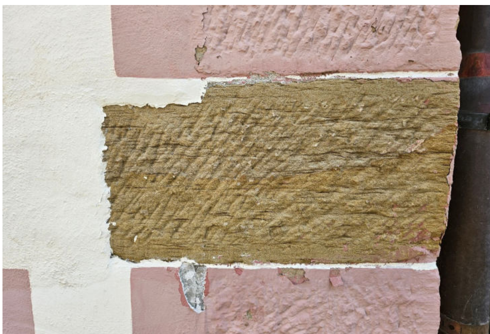
Abb.10 , Ansicht West, Probefläche gereinigt mit Heißdampf
