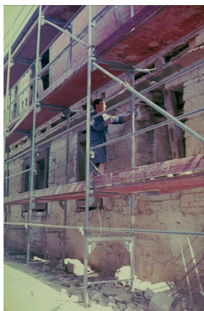
Abb. 17: Südseite während der Instandsetzung 1985-87 (Bild: Archiv Gemeinde Nordheim)
