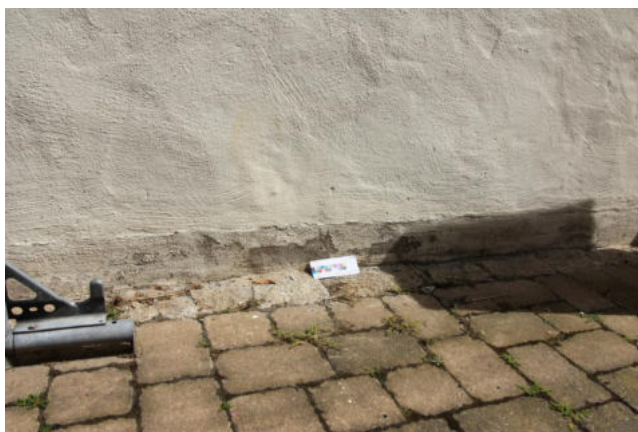
Abb. 21: Dichtschlämme auf der Südseite
