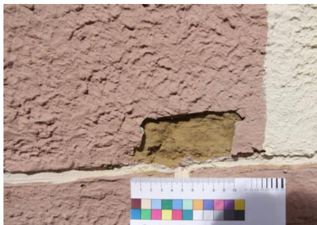
Abb. 20: Ostseite - überputzte Eckquaderung
