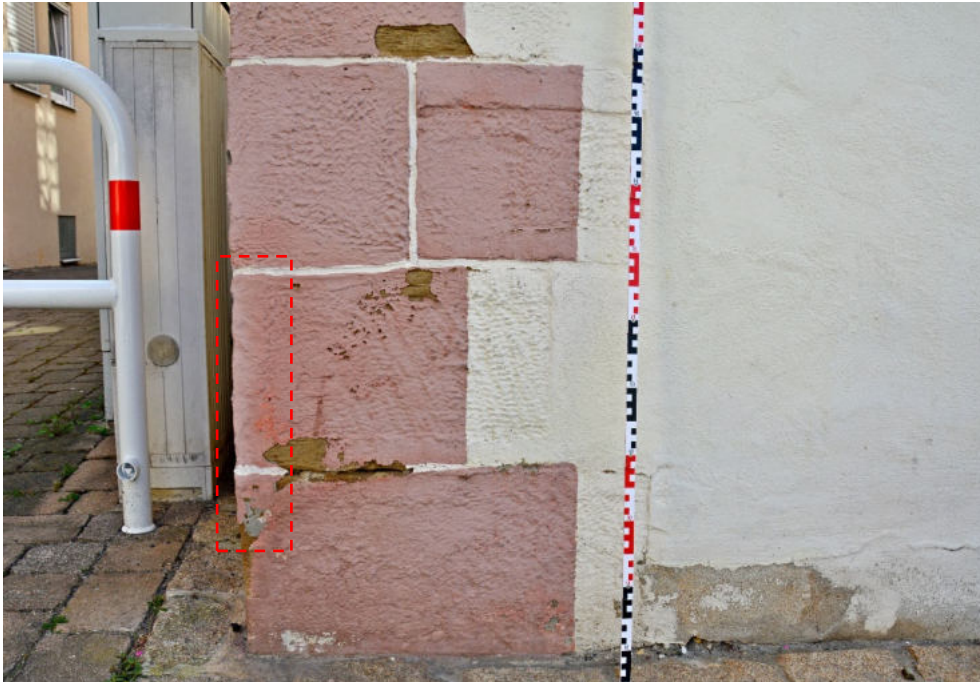
Abb.12 , Ecke Südost, Antragsmaterial, farbiger idealisierter Steinverlauf
