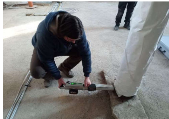
Abbildung 2 Bohrung einer Säule mit historischer Fassung
