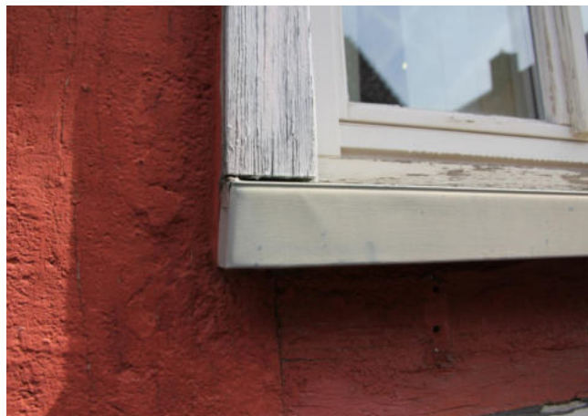
Abb. 29: Blechummantelung der Fensterbank mit dauerelastischer Fuge
