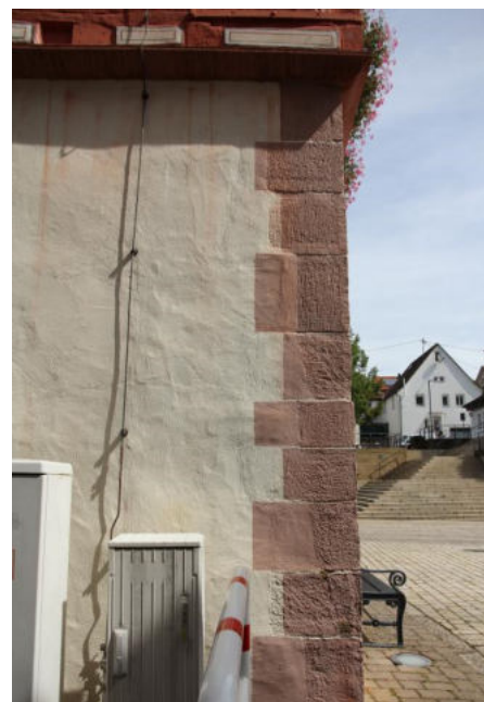
Abb. 19: Südseite mit überputzter und aufgemalter Eckquaderung.
