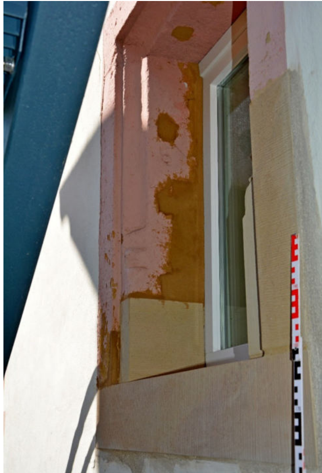
Südseite, vor kurzem gesetzte Vierung und Steinersatzmasse
